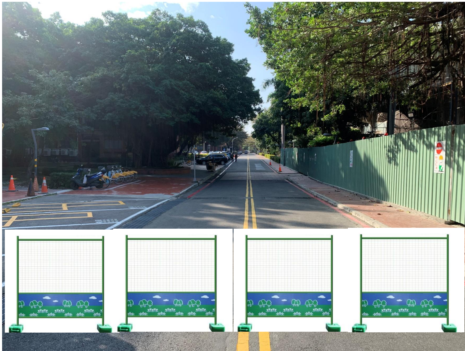
蔣介石行館鋼棚架拆除-乙種圍籬管制範圍(往逸仙館)
